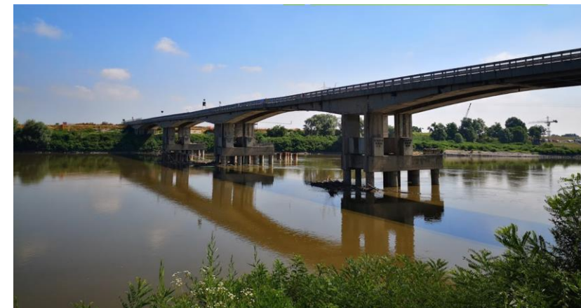
Ponte su selle Gerber monitorato a San Benedetto Po (Mantova)
