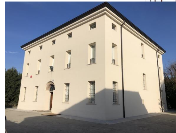
Sistema di monitoraggio installato presso Corte Margonara
