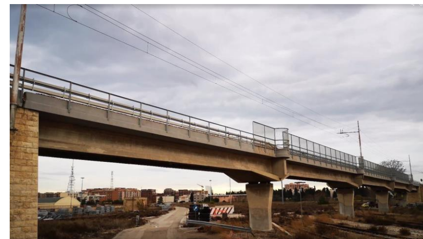
Ponte su selle Gerber monitorato a San Benedetto Po (Mantova)
