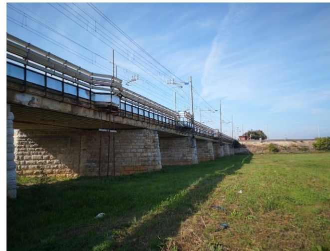
Ponte ferroviario in muratura, località Lamasinata (Bari)
