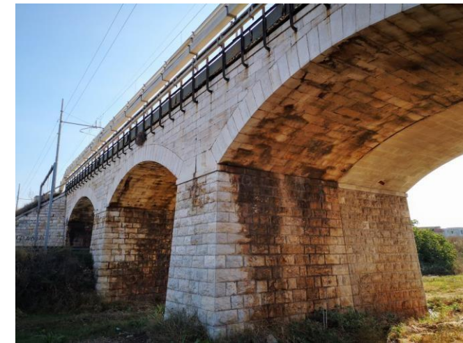
Ponte ferroviario in muratura, località Lama Balice (Bari)
